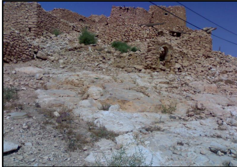
صورة رقم (2) حوائط من مباني قديمة بالحجارة والمادة الرابطة تتكون من الطين والماء
