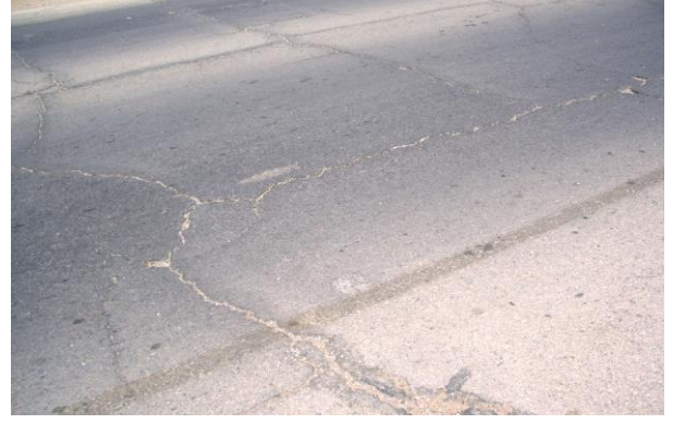
صورة (5) انهيارات الشقوق الانكماشية مدخل طريق براك
