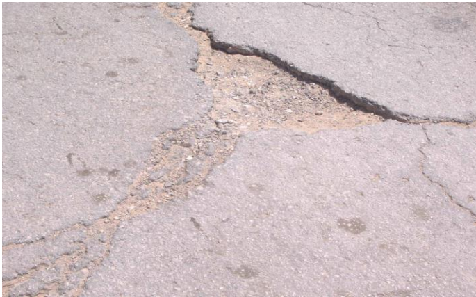
صورة (4) انهيارات حفر Holes مدخل طريق - براك
