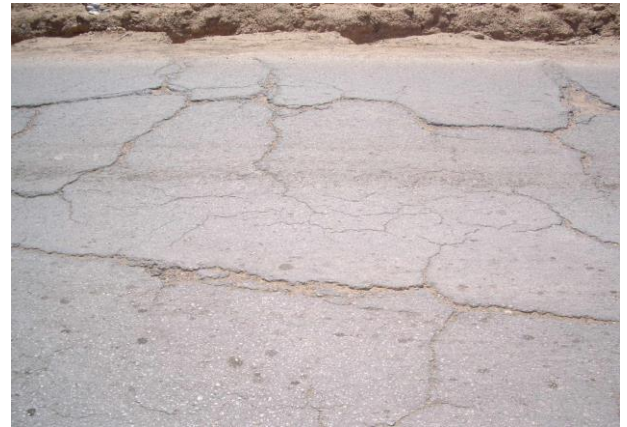
صورة (3) انهيارات الكلال شقوق جلد التمساح (Alligator)
