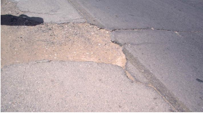
صورة (6) انهيارات حفر Holes في كتف مدخل طريق براك
