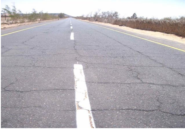
صورة (2) انهيارات شقوق الكلال و الفواصل طولية طريق سبها - براك
