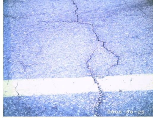
شكل رقم (2) يبين نماذج من الاضرار التي تصيب الرصف الاسفلتي في مناطق الجنوب
