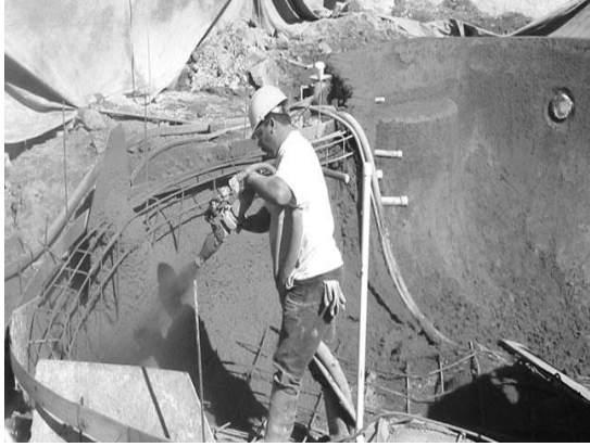
الشكل (3) تنفيذ أسطح وجدران الأحواض
