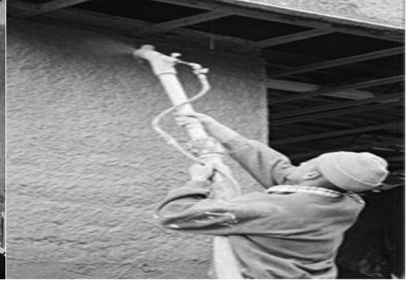
الشكل (2) تنفيذ الأسطح الأفقية والرأسية
