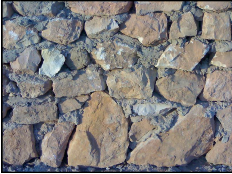
صورة رقم (4) حوائط من مباني حديثة بالحجارة والمادة الرابطة تتكون من الإسمنت والماء
