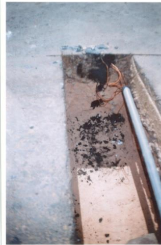
شكل رقم (4) يوضح تثبيت الحساسات الحرارية علي اعماق مختلفة في القطاع
