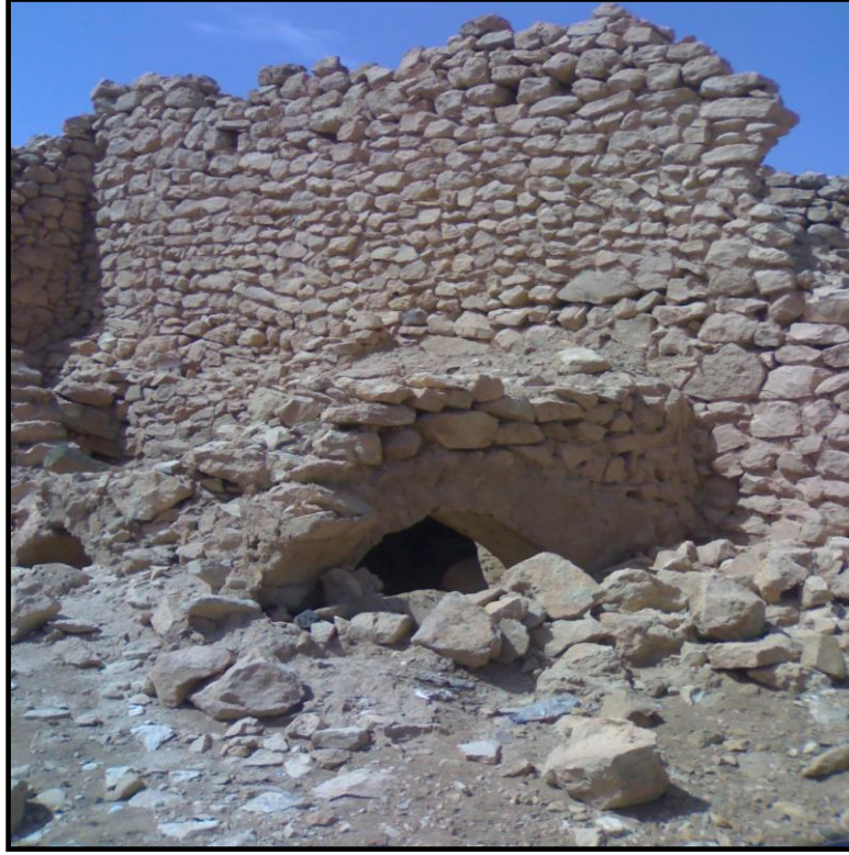
صورة رقم (1) حوائط من مباني قديمة بالحجارة والمادة الرابطة تتكون من الطين والماء
