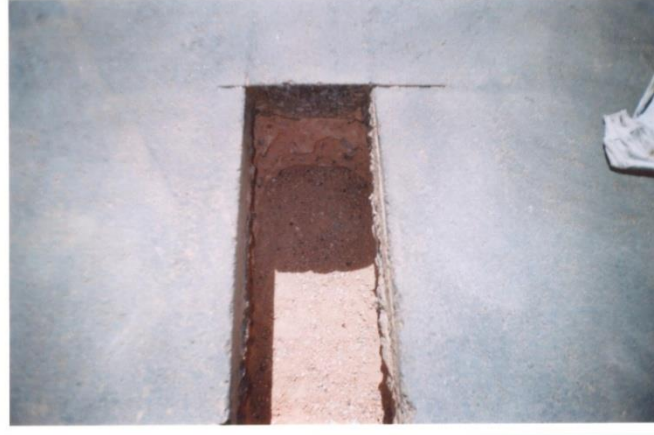
شكل رقم (3) يوضح قطاع في البلاطة الأسفلتية
