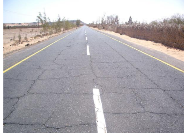
صورة (1) انهيارات شقوق الكلال (جلد التمساح) (Alligator)
